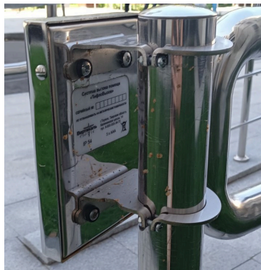
Крепление проводного вызывного устройства
