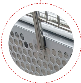
Узел крепления стоек ограждения к маршу пандуса
