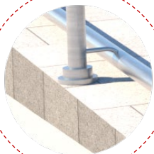
Узел крепления стоек ограждения к маршу пандуса
